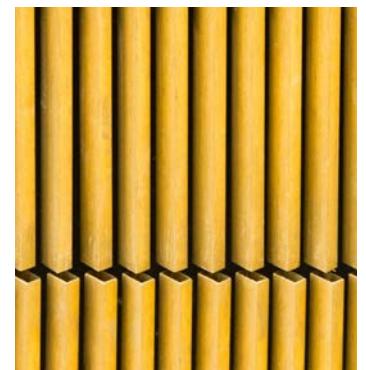
Λεπτομέρεια της πρόσοψης: πλέγμα των μεταλλικών ορειχάλκινων κατατομών
